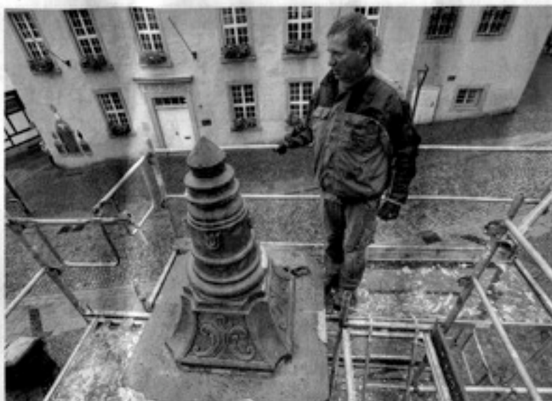
Steinmetz-Meister Herbert Geisthoff stand gestern Vormittag trotz widriger Witterung auf seinem Gerüst und legte Hand an den Maximiliansbrunnen an. Foto: Ted Jones
